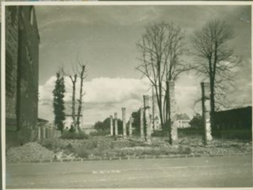
Sodna ul. barake med hišami št 3+7.
