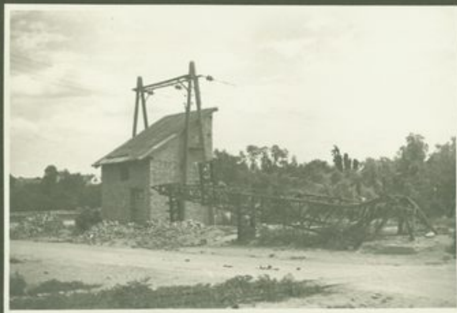
Transformator – Oreško nabrežje
