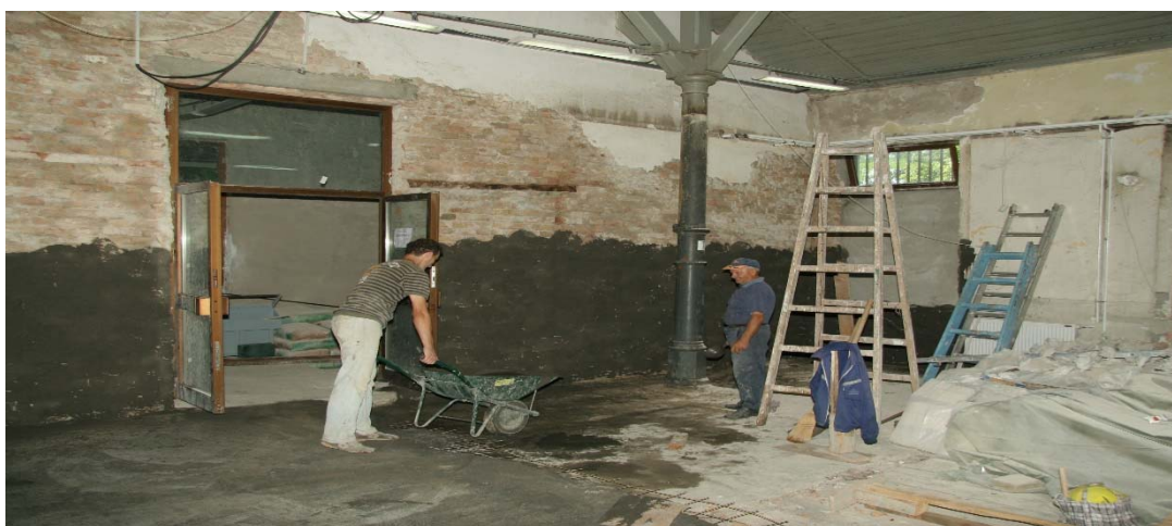
Slika 6: Unutrašnji radovi na rekonstrukciji i adaptaciji depoa Istorijskog arhiva Požarevac, 2008. (IAP)
