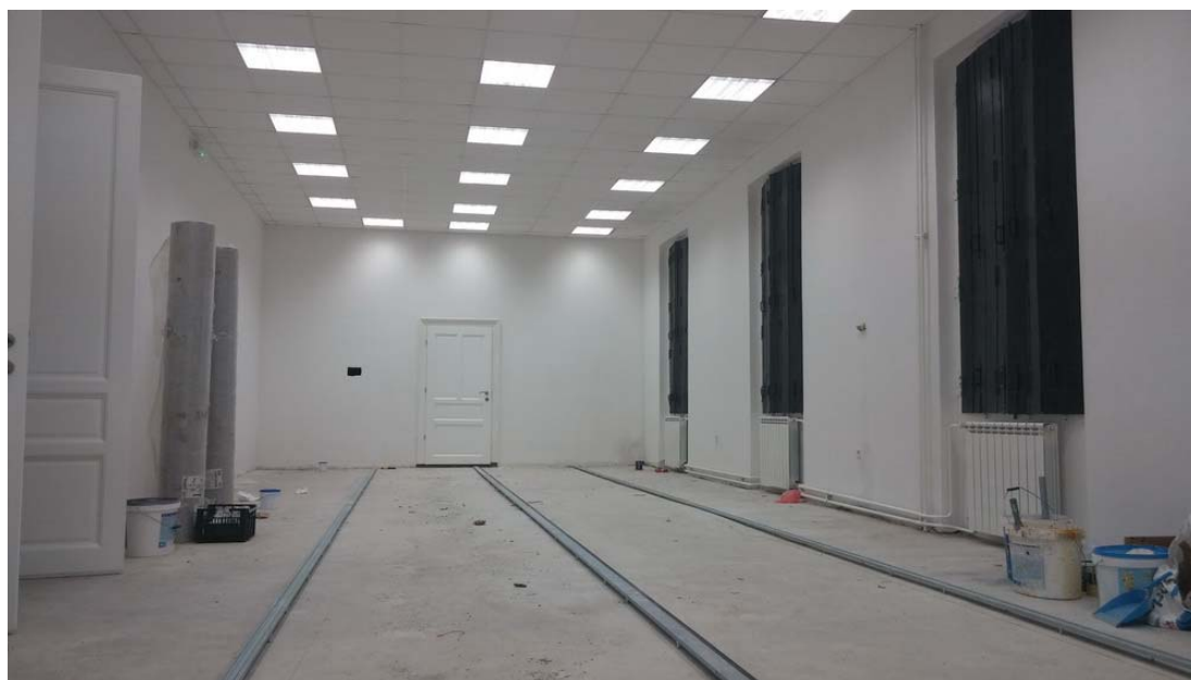
Slika 3: Depo 1 tijekom rekonstrukcije
